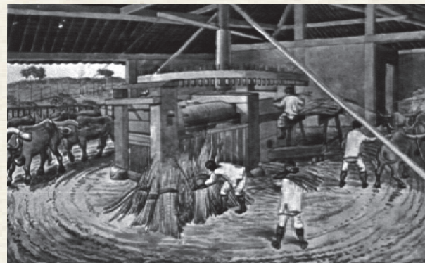
Moenda de açúcar movida por tração animal. Hercules Florence (1804-1879), São Carlos, SP, 1844. Provavelmente, a manjarra descrita pelo contador.
