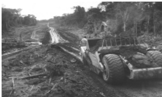
Fotografia 3: Trator faz terraplanagem no terreno da Transamazônica 40 .
